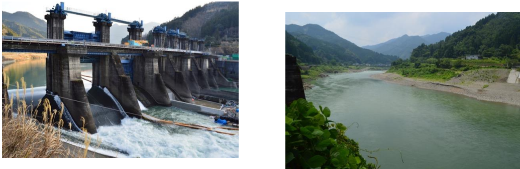
図1 荒瀬ダム撤去前（左、2013年2月）と撤去後（右、2018年8月）の様子（いずれも著者撮影）
